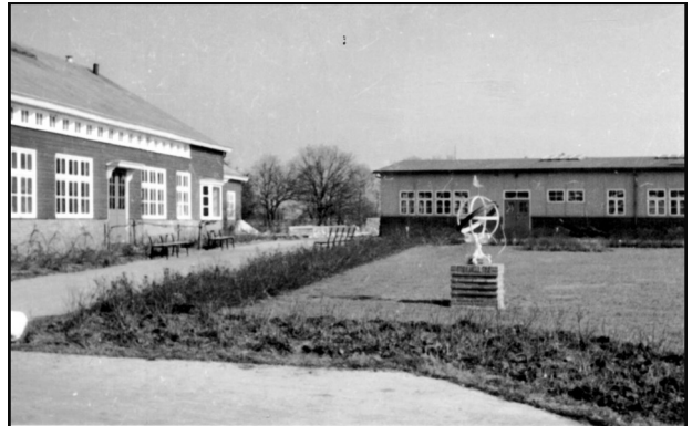
met rechts een nieuw leslokaal en een nieuwe werkplaats
