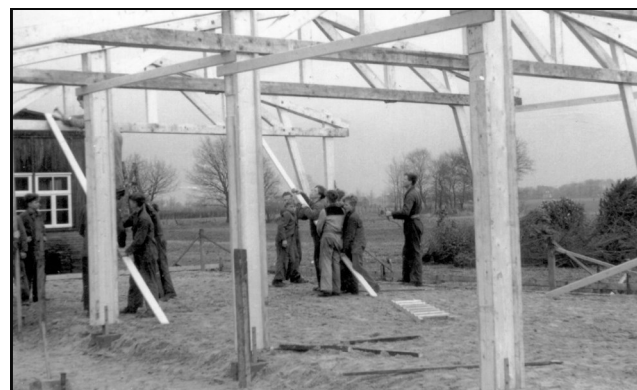
een nieuwe werkplaats wordt opgetrokken
