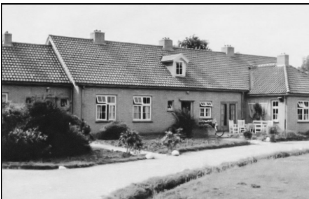
het stafgebouw in een vernieuwde omgeving
